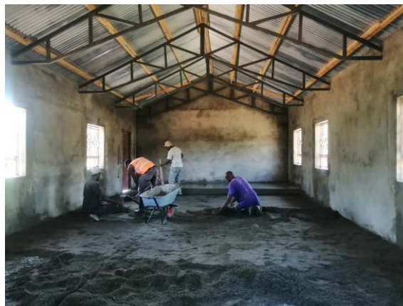
Der er blevet lagt gulv og platform.
